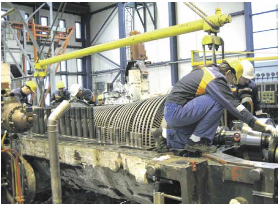
Voimalaitoksen höyryturbiinia ajanmukaistetaan tehon parantamiseksi lähitulevaisuudessa.
