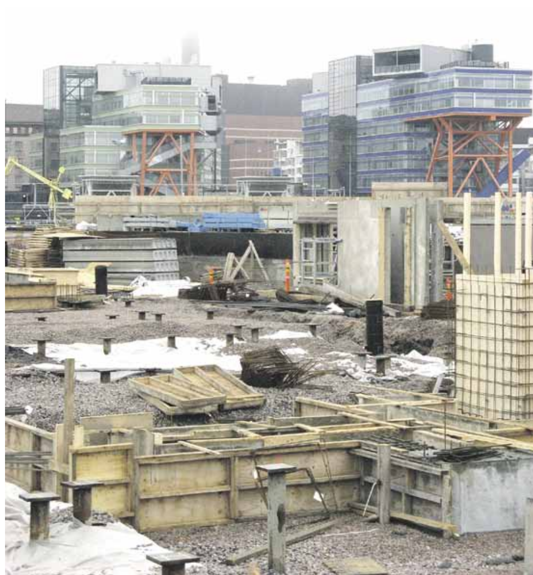
Asunto Oy Paasirannan rakennustyöt on aloitettu ja kohteen arvioidaan valmistuvan alkuvuodesta 2013.
