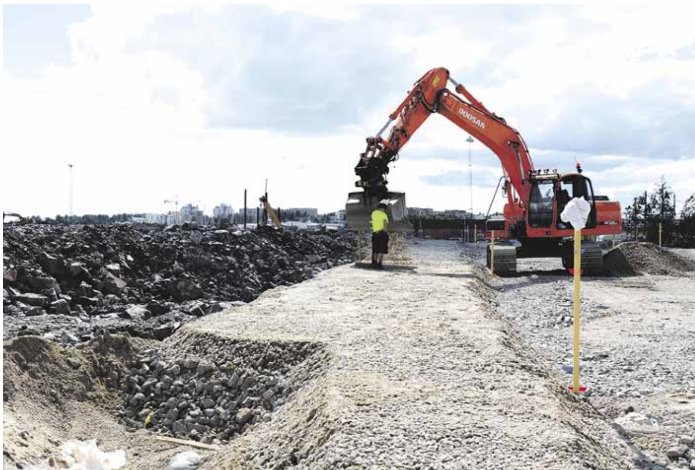
Jätkäsaaren rakentamista heinäkuussa 2011. Kuva: Teina Ryyänen/KSV
