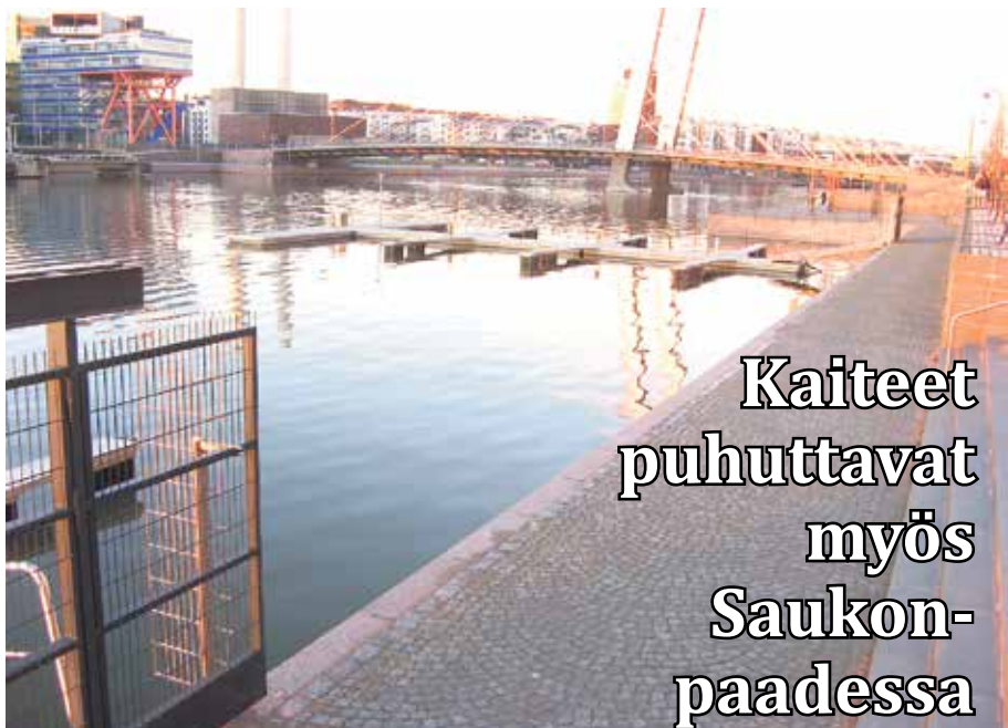
Puuttuvat kaiteet huolestuttavat Saukonpaadessa.
