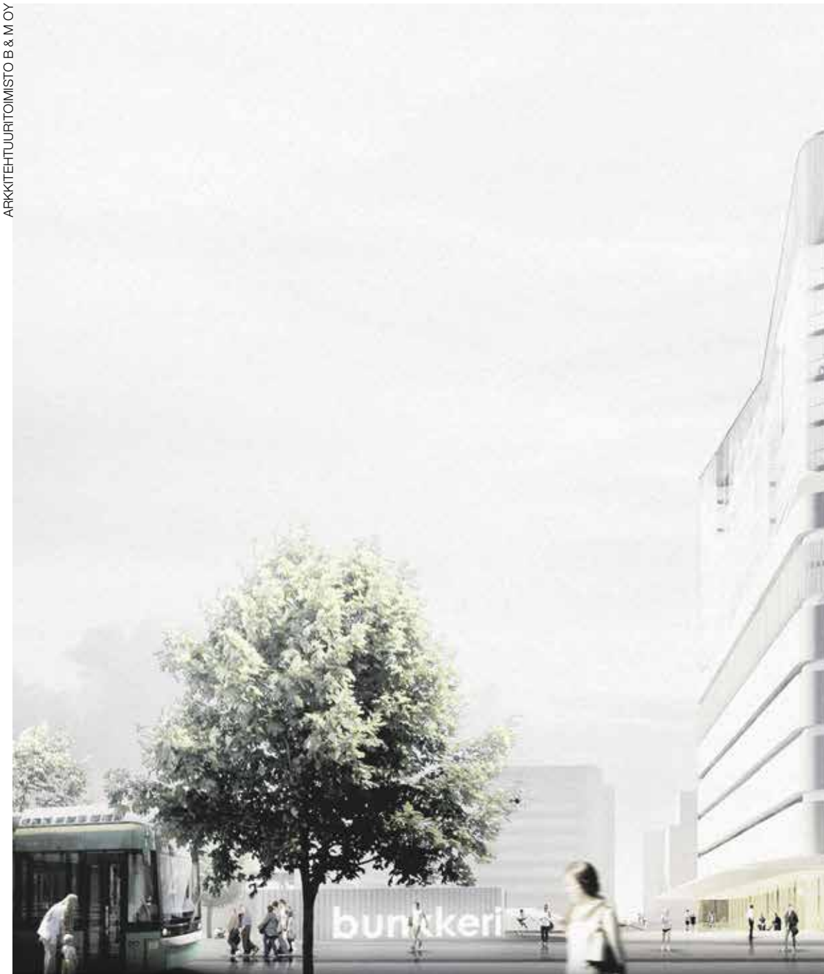
Bunkkerista puretaan kolme kerrosta ja rakennetaan yhteensä kymmenen kerrosta asuntoja. Ensimmäisen kerroksesta lähtien on asuntoja.
