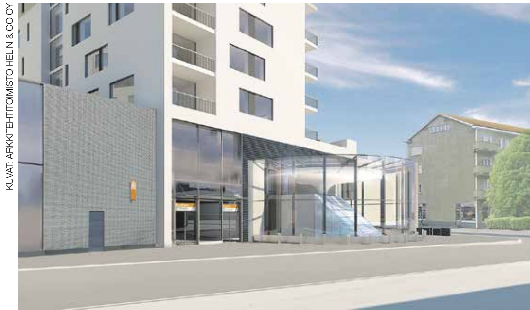
Lahtisaaren metroaseman tyylikäs pääsisäänkäynti.
