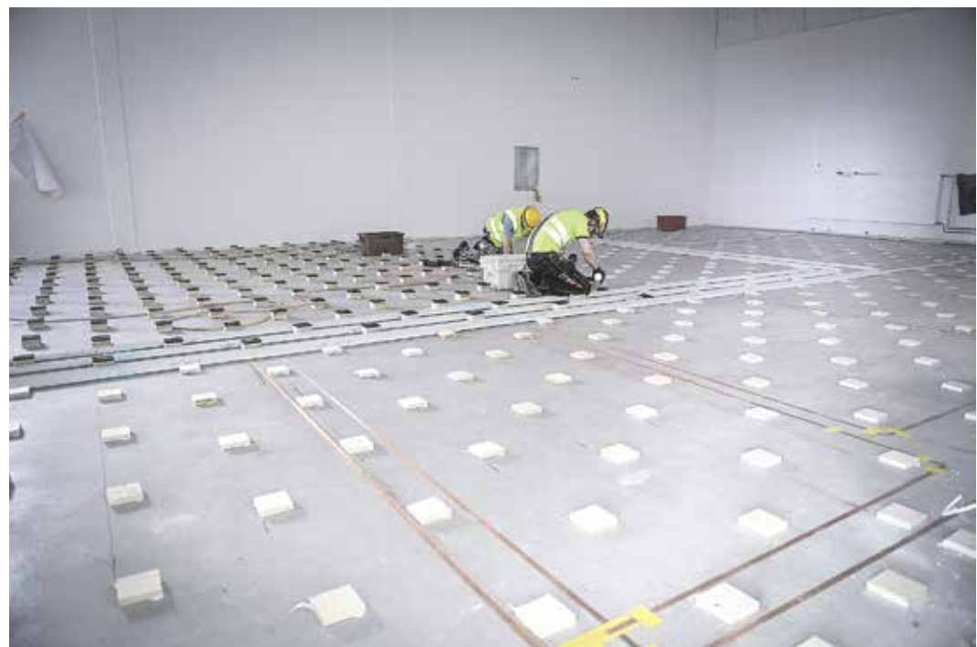
Kohta täällä kirmataan. Liikuntasaliin asennetaan joustava lattia.
