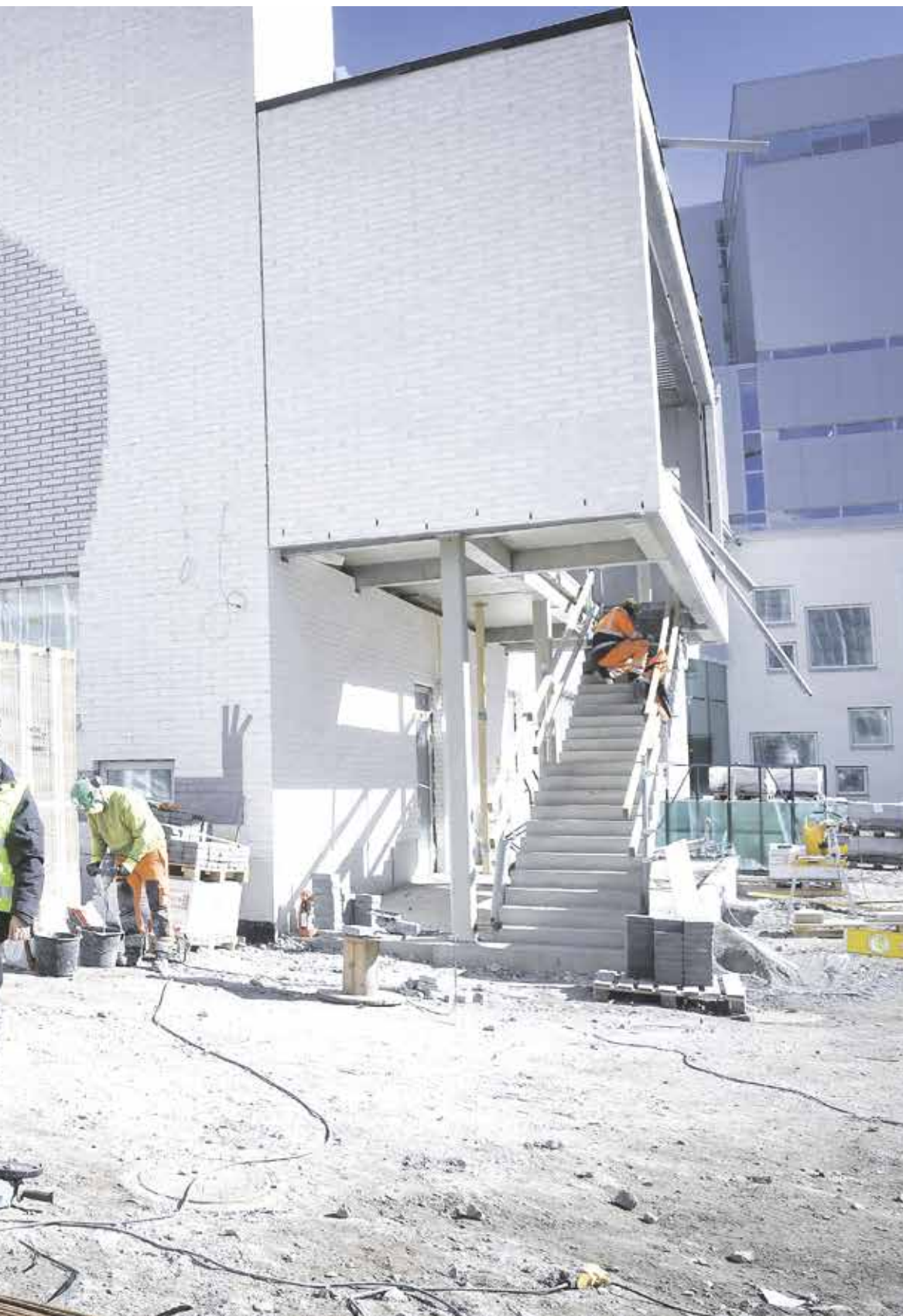
Rakennuksen ympäriltä on purettu, ja töitä tehdään nyt pääasiassa sisätiloissa.
