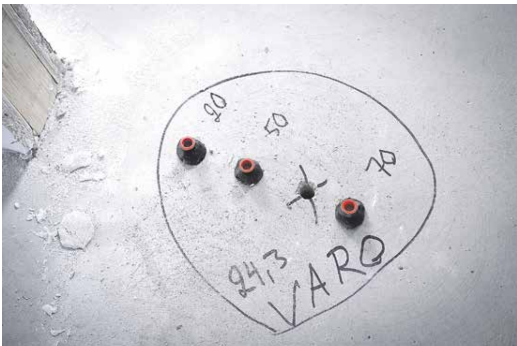
Betonin kuivuusaste todetaan porarei'istä mittaamalla. Mittaus tehdään standardoidulla menetelmällä.
