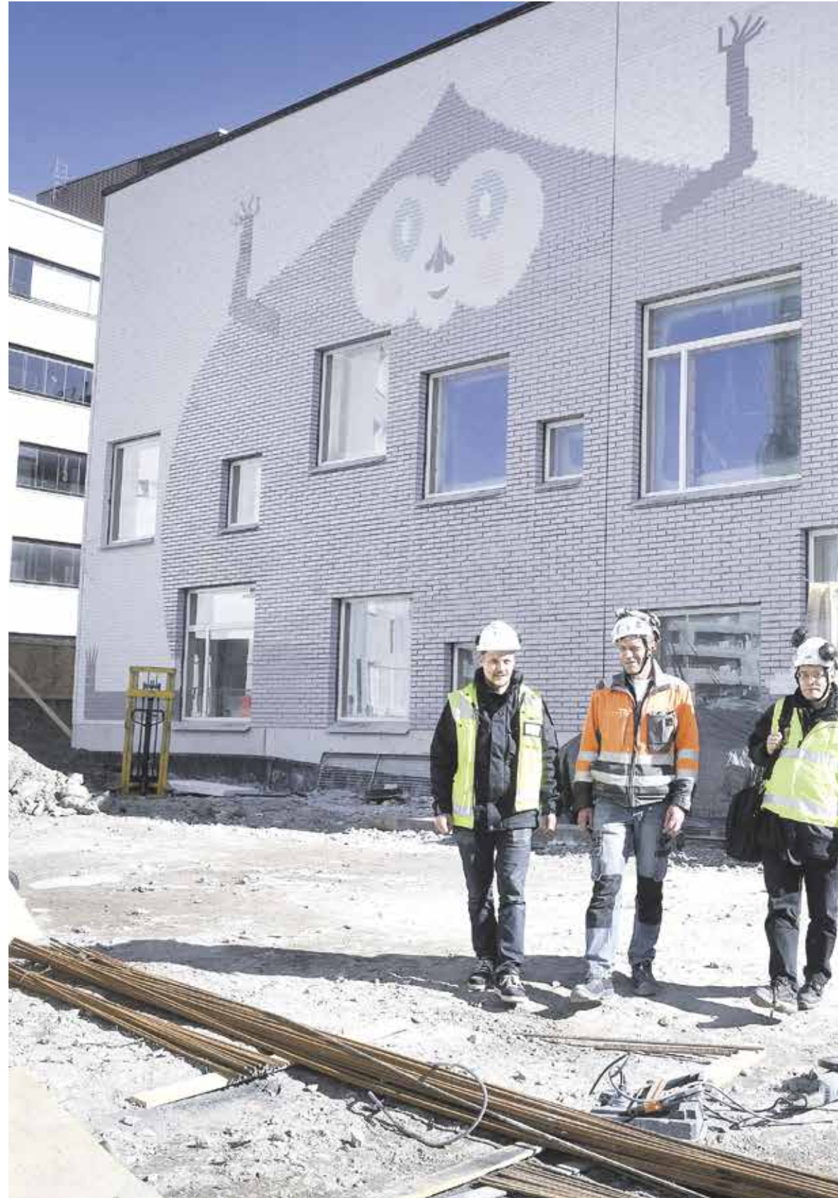
Juha-Pekka Purtilo, Kari Luoma ja Vesa Isakov ovat tyytyväisiä rakennusurakan edistymiseen. Sääsuojat
