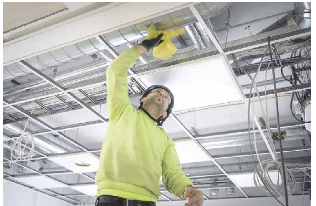
Lirim Krasniqi puhdistaa alakaton yläpuolista osaa. Kun tila todetaan puhtaaksi, voidaan se sulkea.
