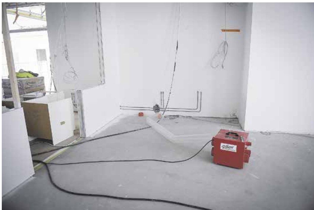
Betonin kuivumista voidaan jouduttaa ilmankuivaimien avulla.
