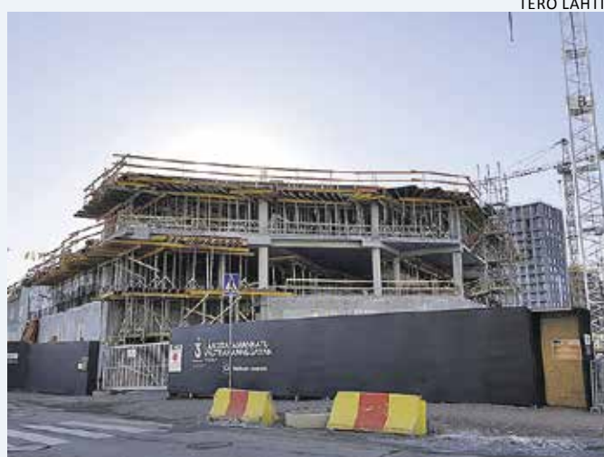
Lidliä ja pysäköintitaloa rakennetaan parhaillaan Länsisatamankadun varteen.
