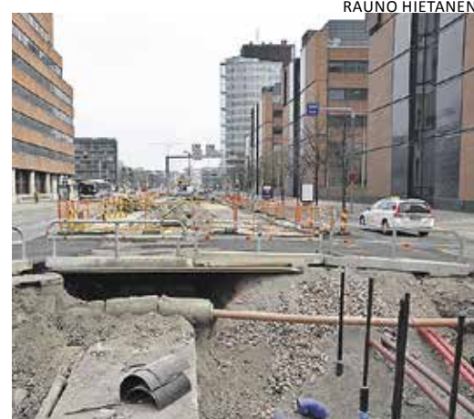
Vesihuoltoverkoston saneeraustyöt haittaavat liikennettä Porkkalankadulla tämän kesän.
