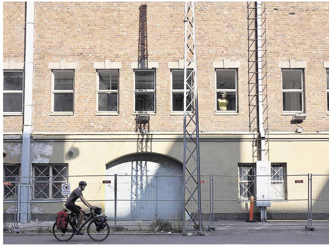
Länsisataman vieressä sijaitseva vanha L3-makasiini on toiminut alun perin sataman varastorakennuksena.
