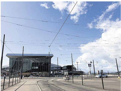
Länsiterminaali 2:n edustaa valaisee vaijereihin ja led-valaisimin rakennettu valoverkko.
