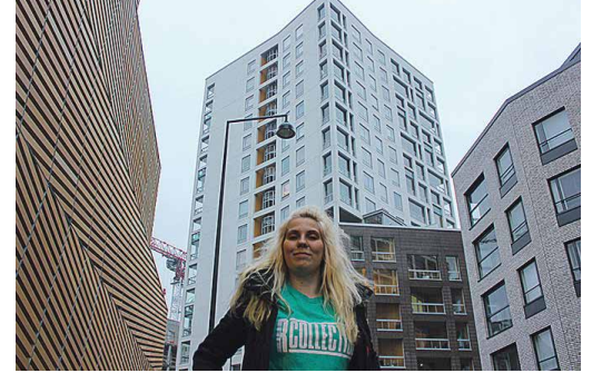
Kirsi Pörhö muutti vastavalmistuneeseen Pollarin tornitaloon. Talossa on yli sata asuntoa.
