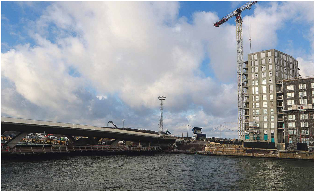
Atlantinsillan rakentaminen etenee aikataulussaan. Käyttövalmis sen pitäisi olla keväällä 2021.
