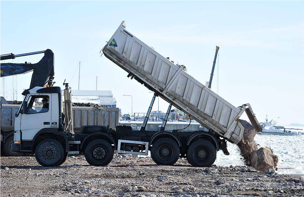
Länsimetron rakentamisessa muodostui maanrakennuksessa käytettävää louhetta noin 300 000 kuorma-auton lavallista.
